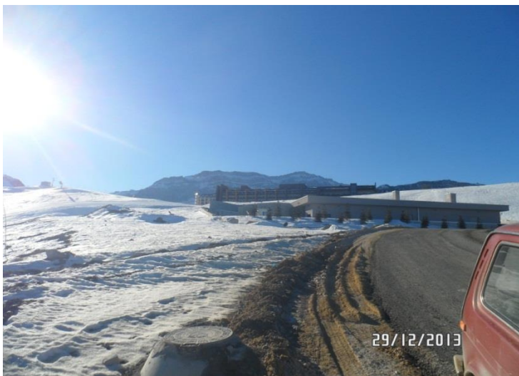
Отопительный центр курорта.
